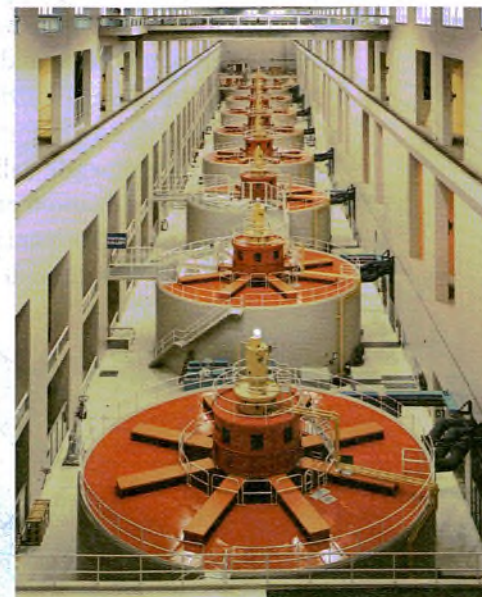
Sala alternatori La foto mostra la sala di una centrale in caverna con 10 alternatori. Sotto ogni alternatore, al livello inferiore, c'è la turbina che lo fa girare.
